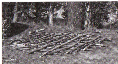
Faites un modèle avec des perches sur le sol.
