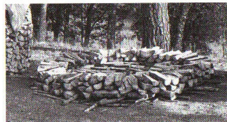
Faites un "sol perdu" de bois fendu sur les perches. Tournez le côté des écorces vers le bas.
